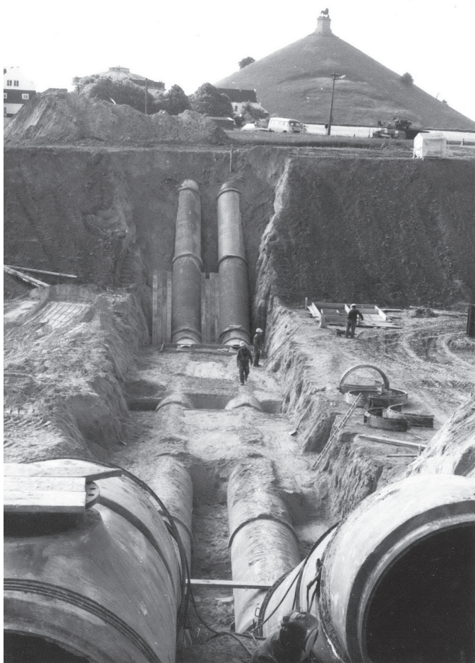
Pose d'un siphon sous une bretelle d'autoroute à Braine-l'Alleud Archives photographiques Vivaqua
